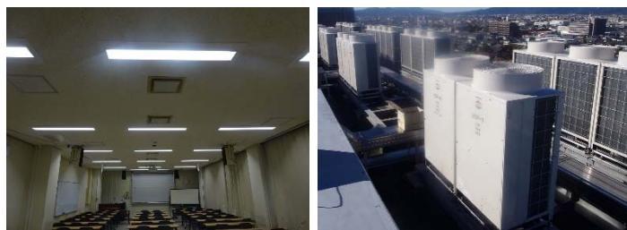
(省エネ改修 LED照明設備・高効率空調設備等)
